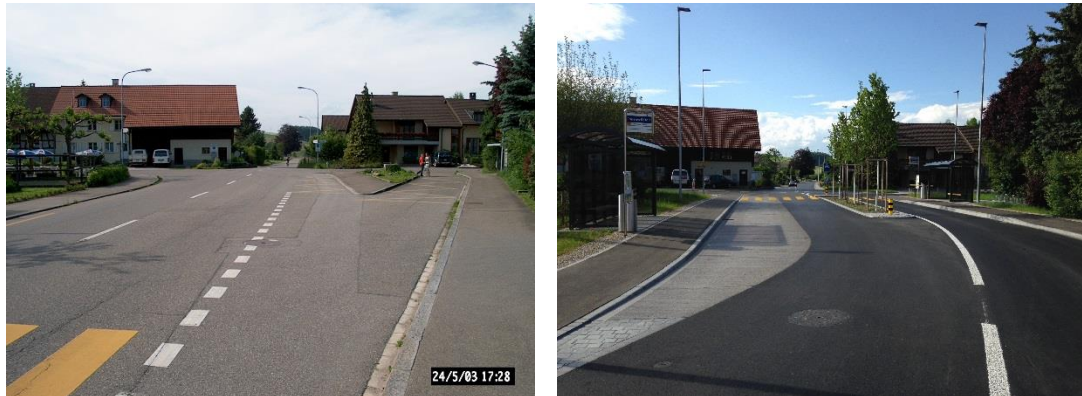
Abbildung 1: Ansicht Freienwil Mitte vor und nach der Strassensanierung
