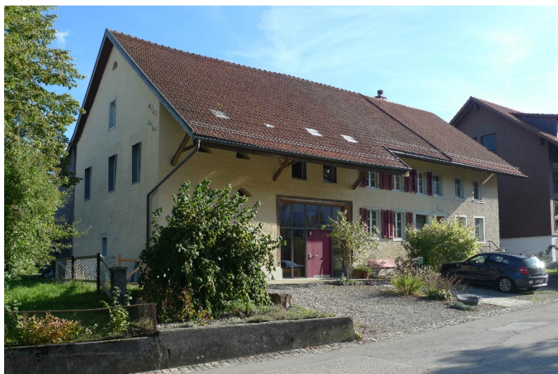
Ansicht von Norden (2019)
