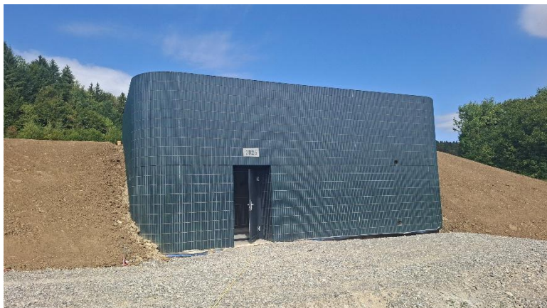
Neues Trinkwasserreservoir der Gemeinde Freienwil
