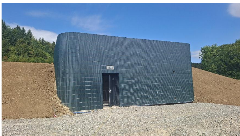
Neues Trinkwasserreservoir der Gemeinde Freienwil
